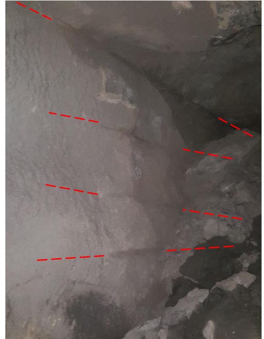
Figura 54 - C6602B03: Verificação da estabilidade da rocha remanescente, onde são visíveis as marcas das canas de contorno nos hasteais e no tecto.
