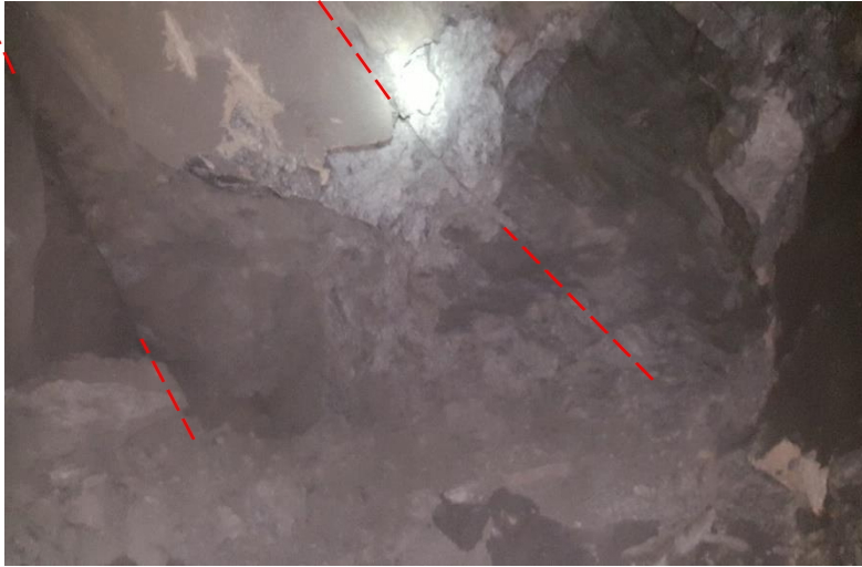
Figura 54 - C6602B03: Verificação da estabilidade da rocha remanescente, onde são visíveis as marcas das canas de contorno nos hasteais e no tecto.
