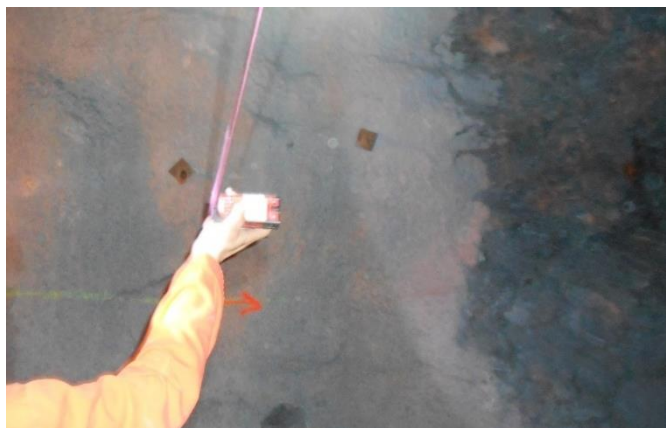
Figura 46 - Recolha das medições entre os offsets implantados e a frente de trabalho.
