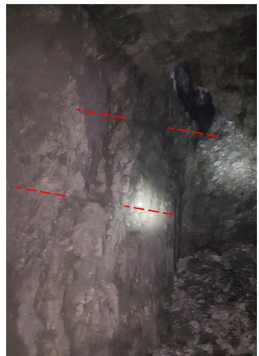
Figura 53 - LS395B065: Verificação da estabilidade da rocha remanescente, onde são visíveis as marcas das canas de contorno nos hasteais e no tecto.
