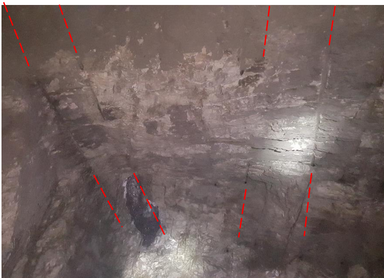
Figura 53 - LS395B065: Verificação da estabilidade da rocha remanescente, onde são visíveis as marcas das canas de contorno nos hasteais e no tecto.
