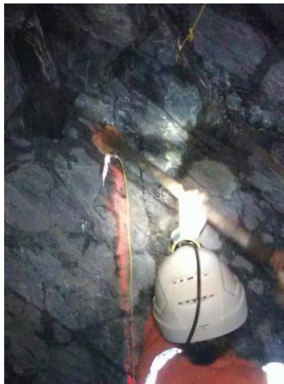
Figura 39 - Aplicação de argila num furo com explosivo.
