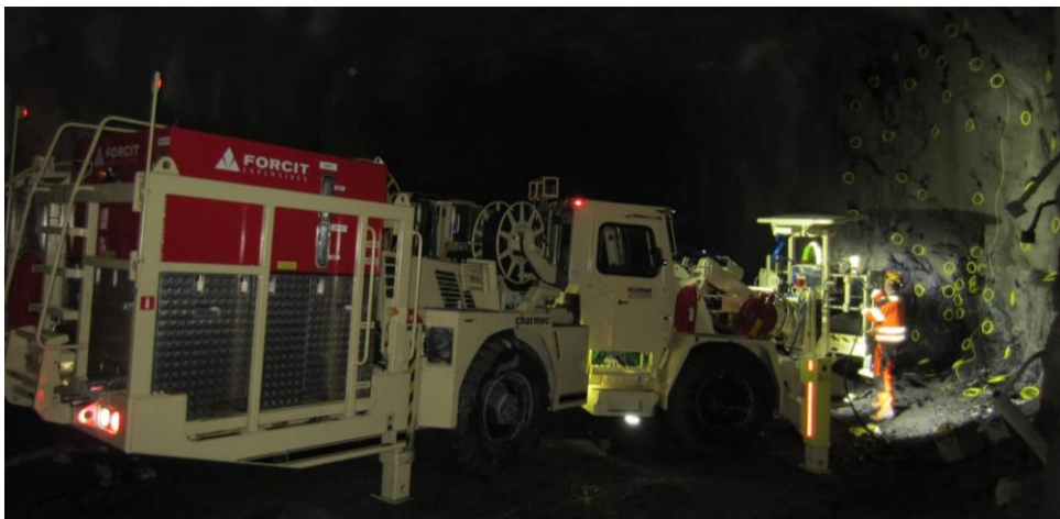
Figura 16 - Carregamento mecanizado de uma frente (Fonte: normet.com ).
